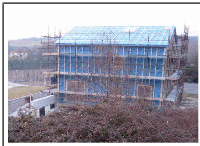
Vista dall'esterno dell'edificio
