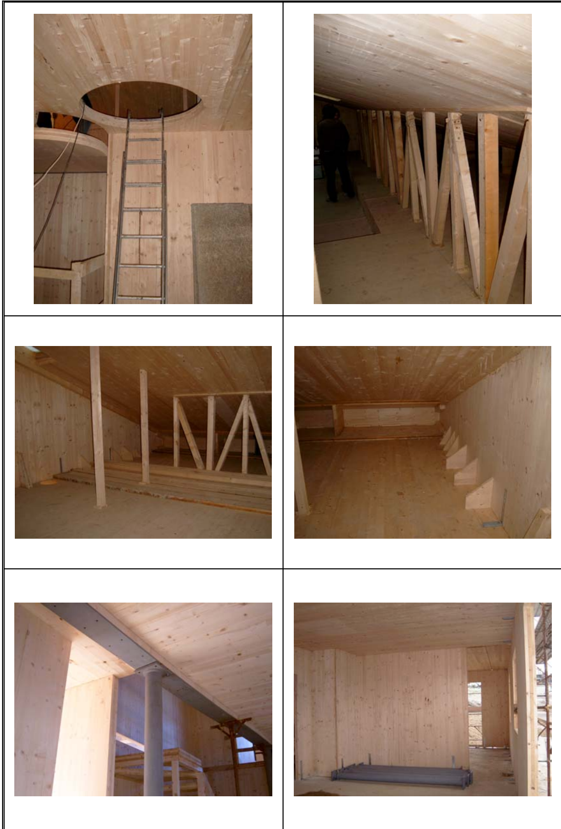
Alcune fasi di costruzione
