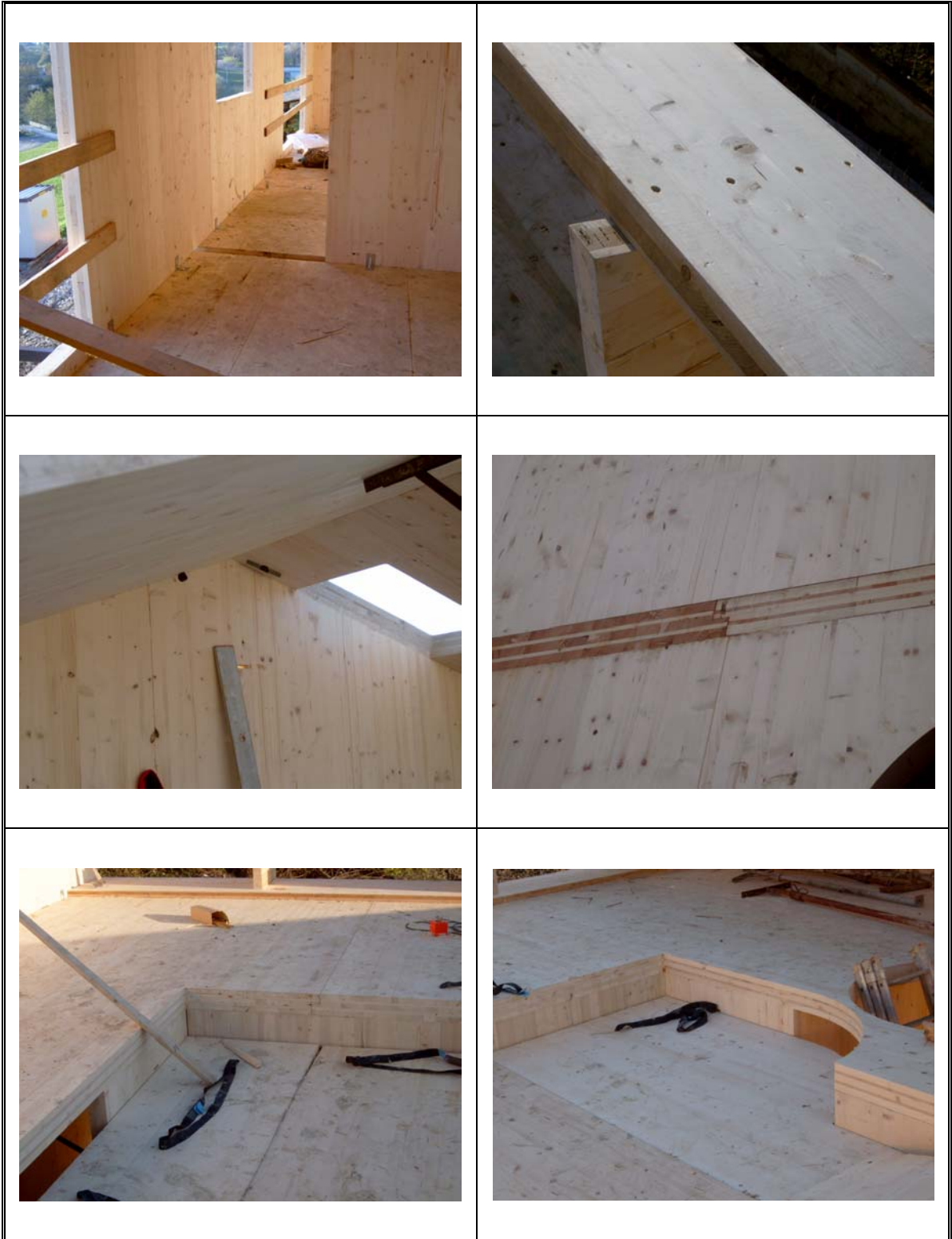
Aspetto dei pannelli strutturali appena posati
