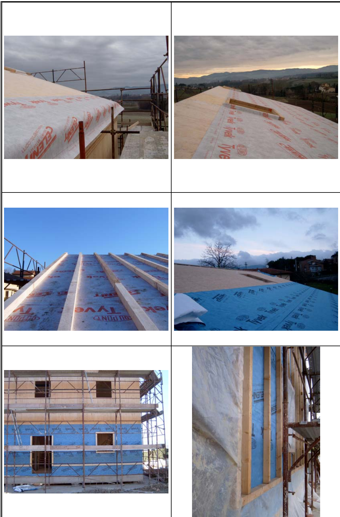
Alcuni dettagli della protezione esterna
