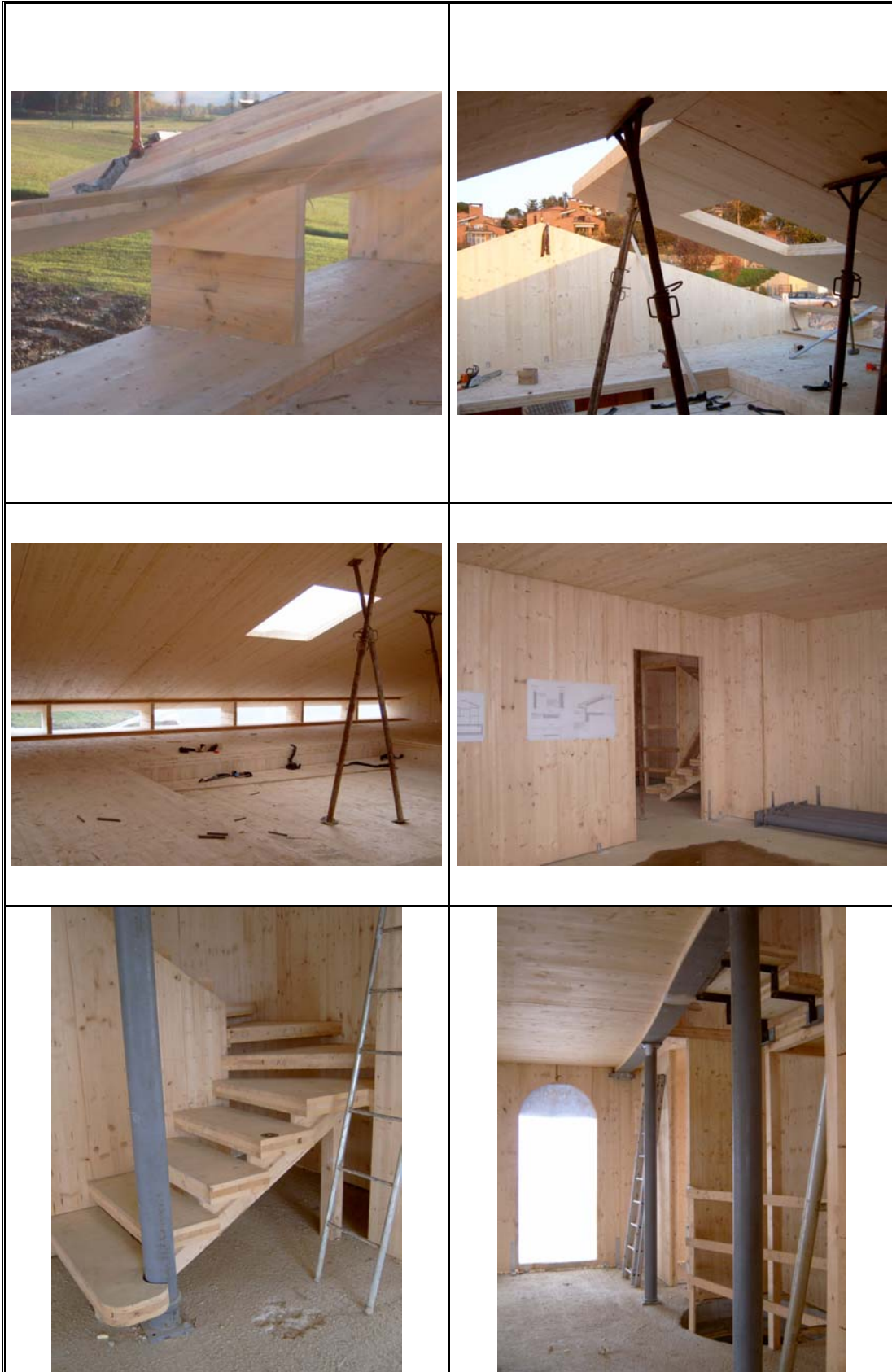
Alcune fasi di costruzione
