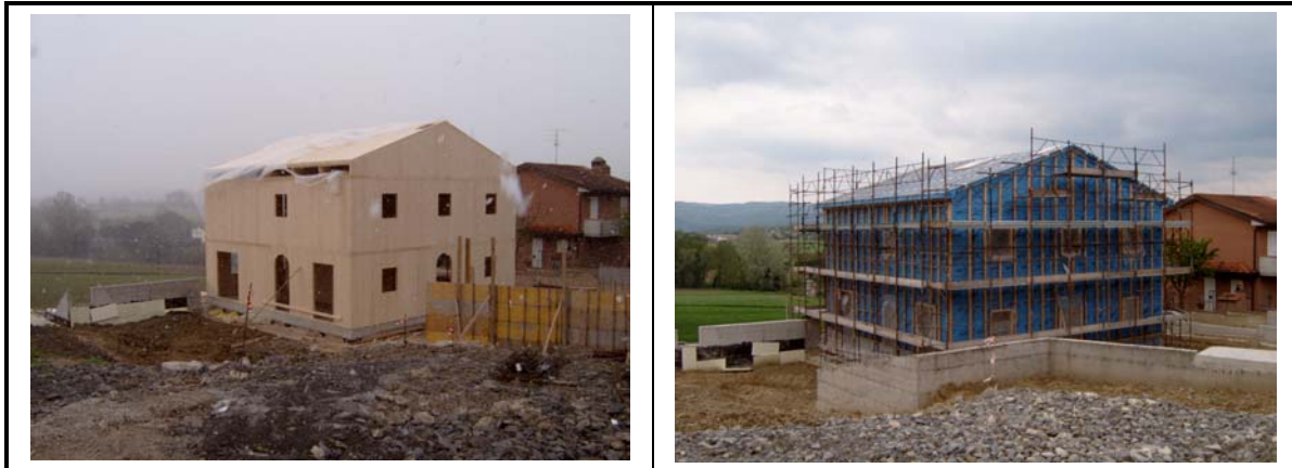
Viste della Casa...Jazz, a struttura appena ultimata ed in fase di realizzazione della protezione esterna.
