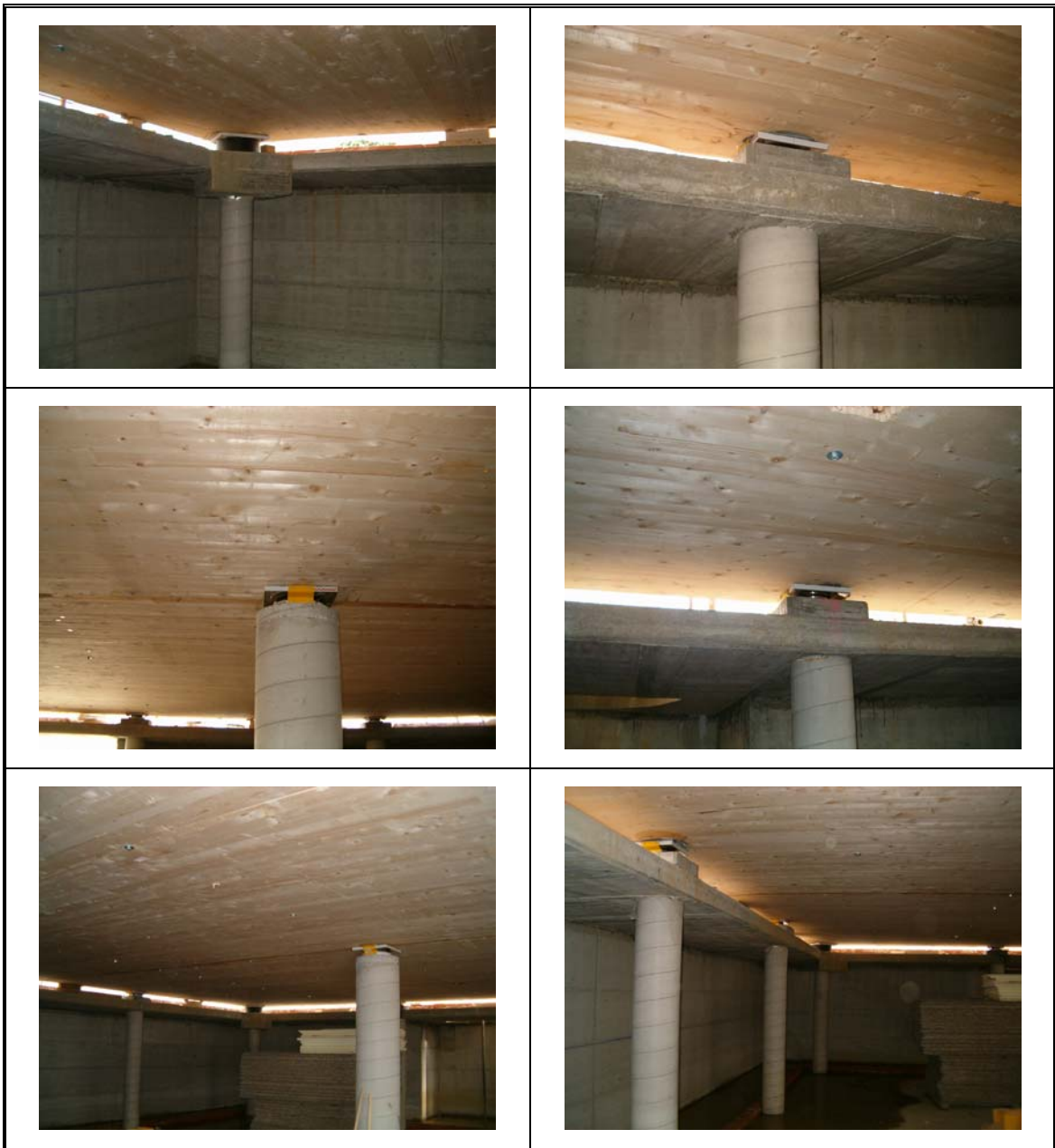
Alcune viste degli isolatori e degli appoggi a struttura ultimata.
