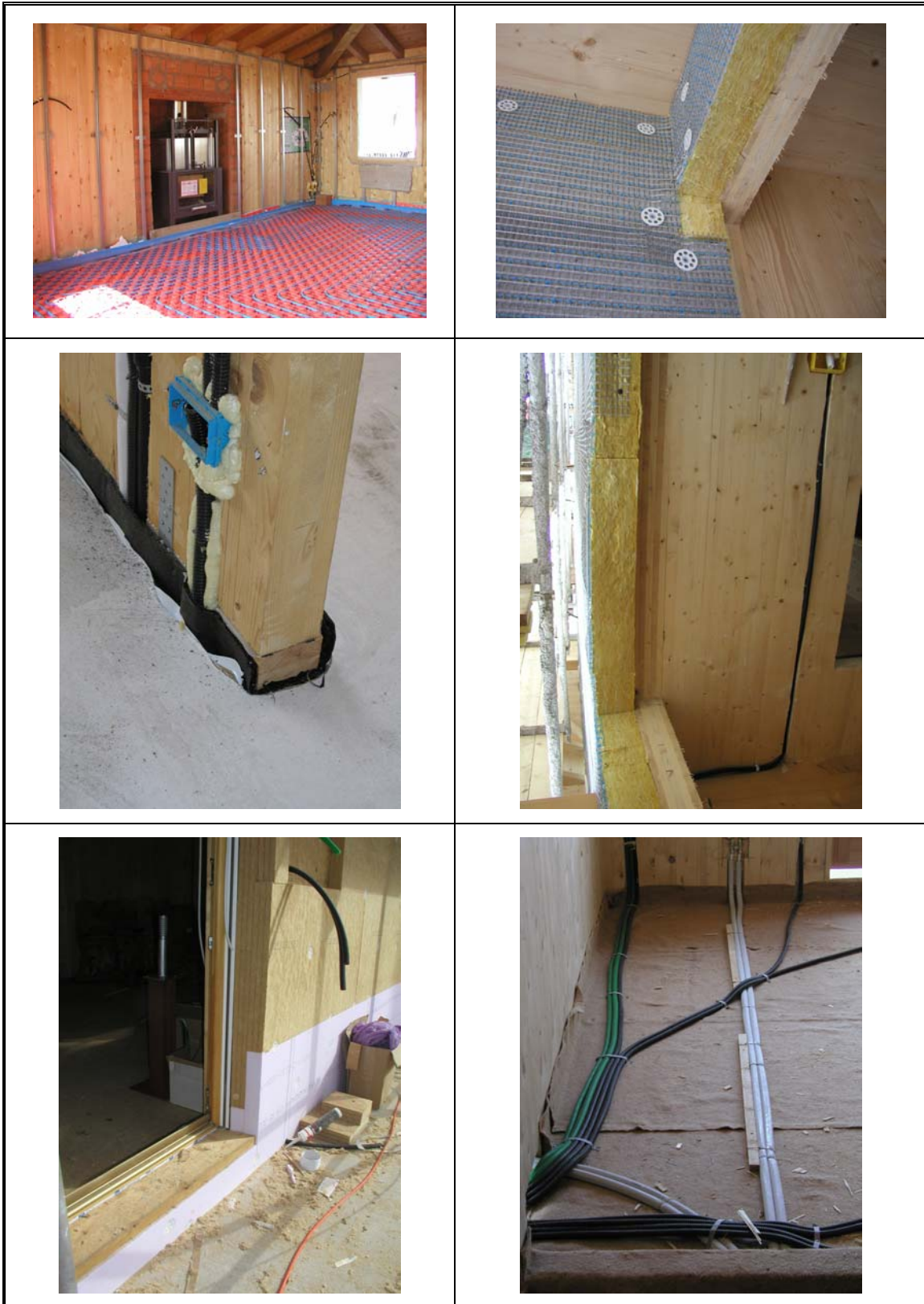
Particolari di posa impianti.
