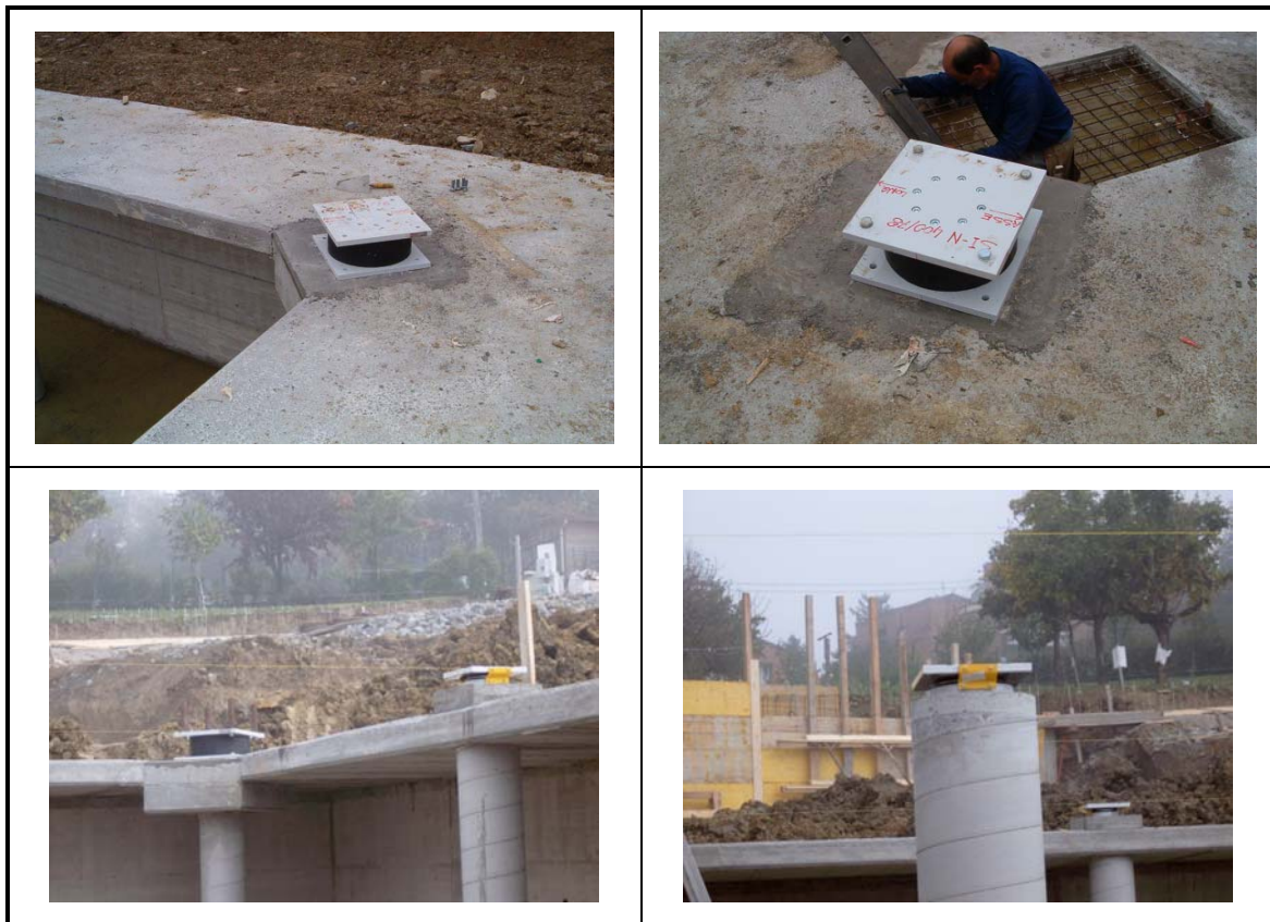
Alcune viste degli isolatori e degli appoggi prima del getto della soletta del solaio P.T..
